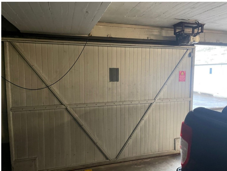
Tor vorher (Innenansicht)
